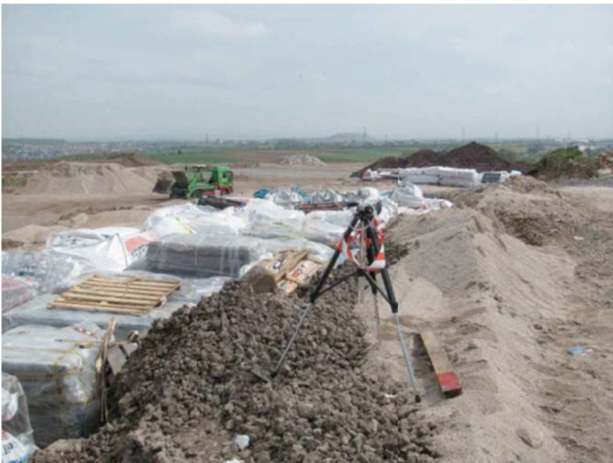
Abb. 10.1: Messstelle an der Asbest Einbaufläche
