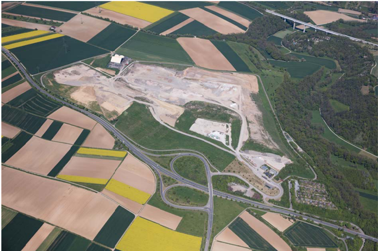
Abb. 1.1: Schrägaufnahme aus südlicher Richtung auf die Deponie im Mai 2016
