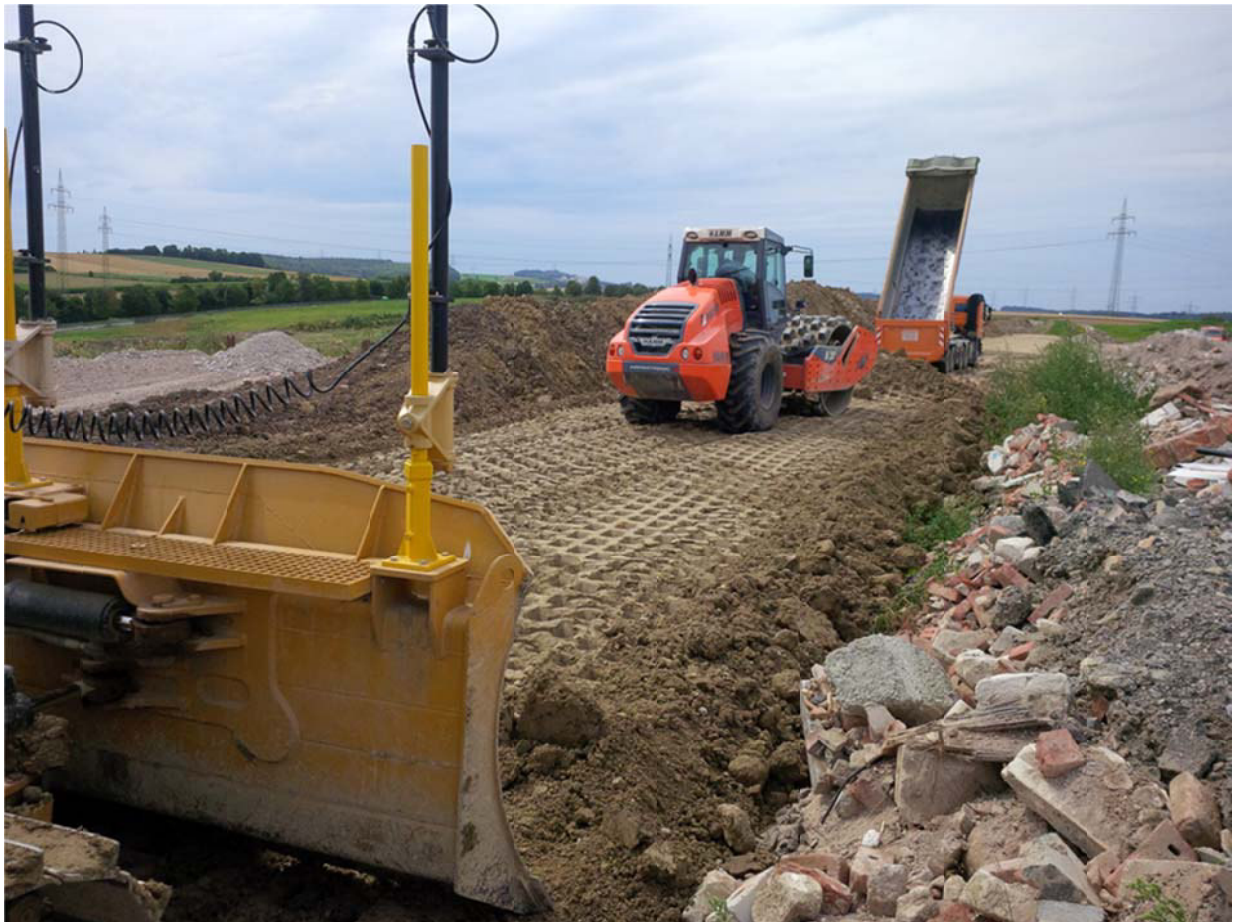
Abb. 4.1: Materialeinbau am Trenndamm TD 6
