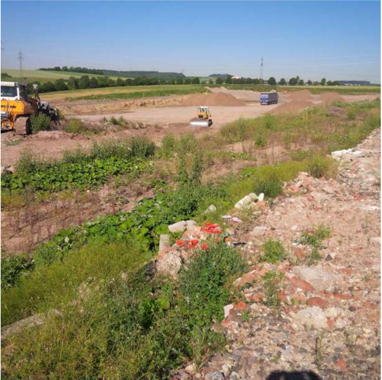
Blick auf die Einbaufläche DK 0 Bauabschnitt 5
