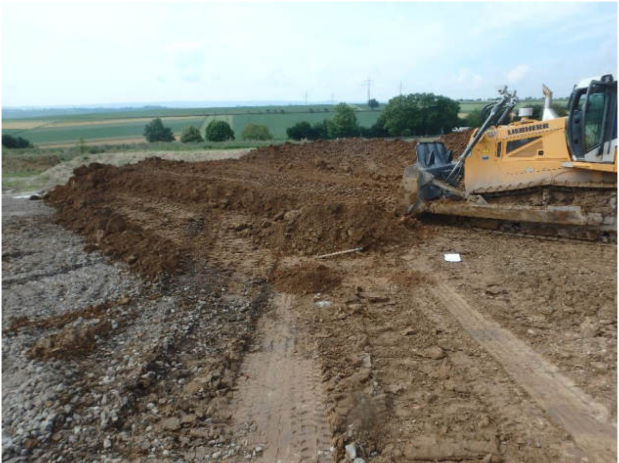
Einbau von Rekultivierungsmaterial im Bereich DK 0, Bauabschnitt 4.1
