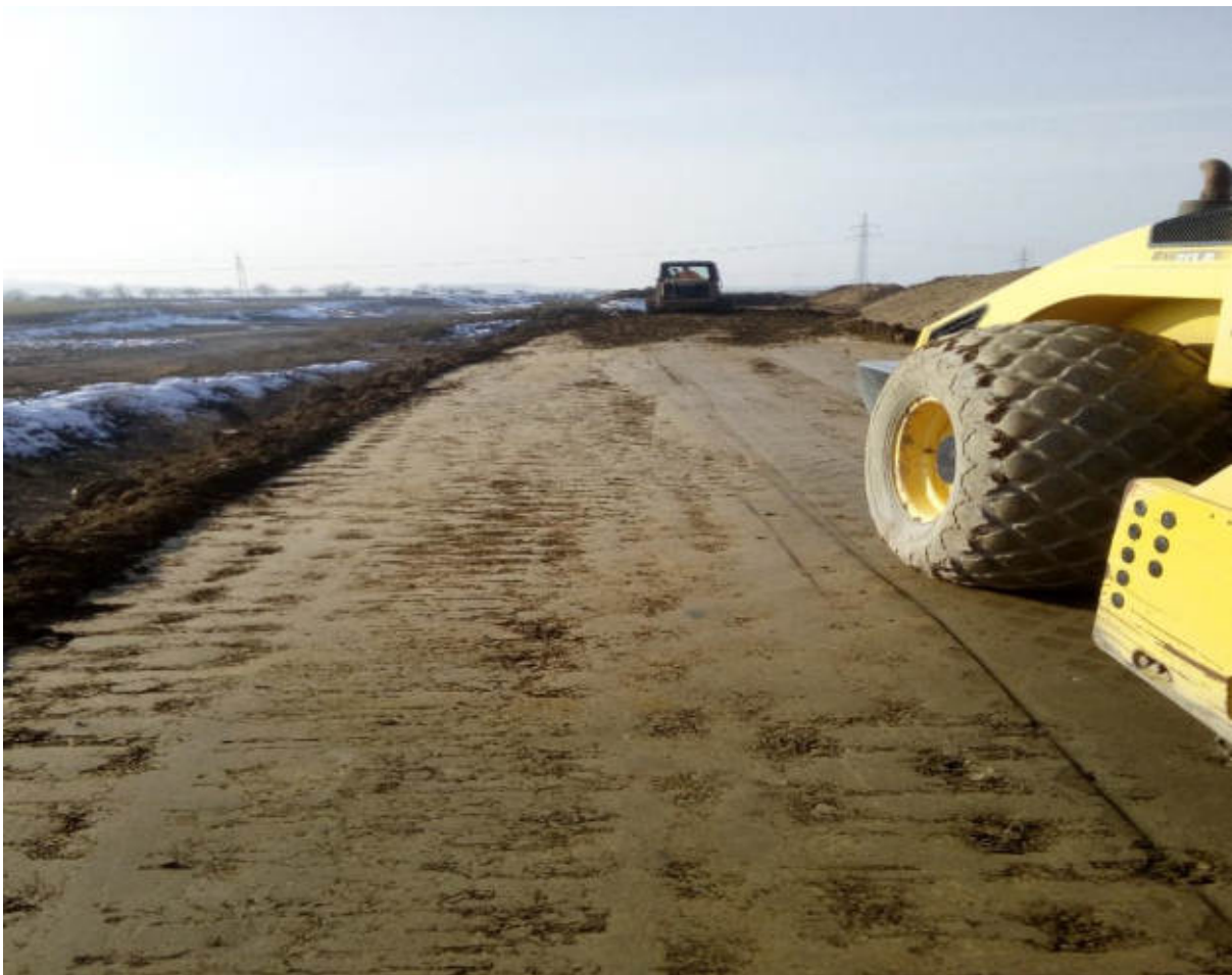
Abb. 4.1: Materialeinbau am Trenndamm TD 6
