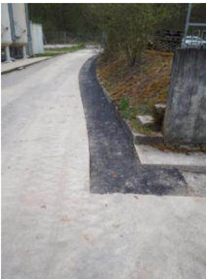
Abb. 16: Neue Stromleitung SÜWAG Stromverteilerkasten
