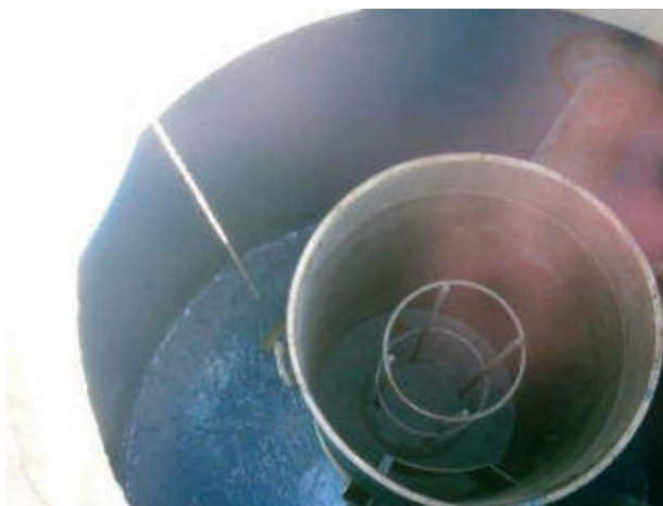
Abb. 8: Innenbeschichtung Koaleszenzabscheider
