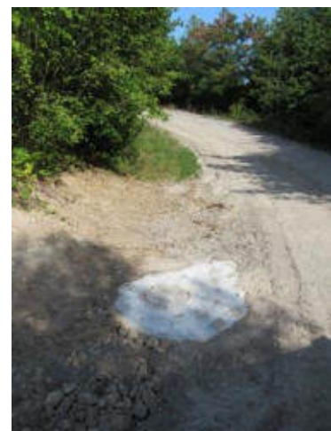
Abb. 4: Höhersetzung Schacht
