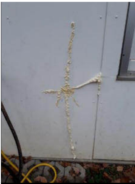
Abb. 19: Versiegelung mit Bauschaum
