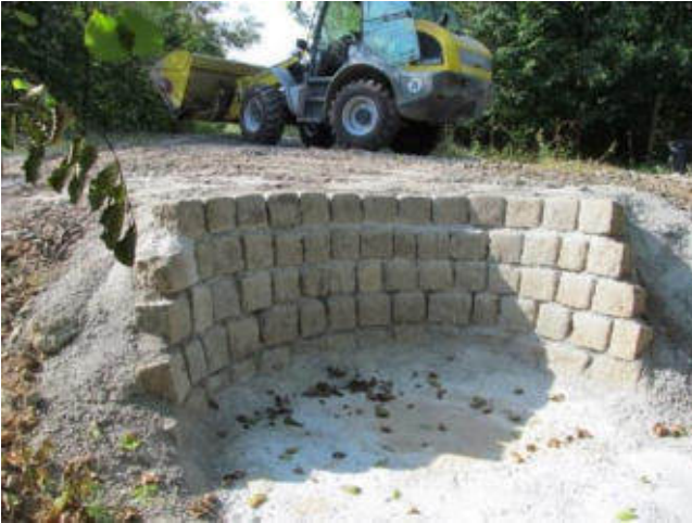
Abb. 5: Ausbesserungen Oberflächenwasserschächte
