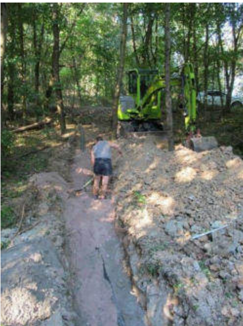
Abb. 6: Einbettung Gasleitung
