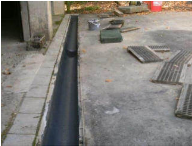
Abb. 7: Abdichtung der Bircorinne
