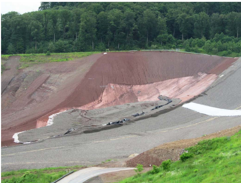
Abb. 11.1: Partielle Teilrutschung innerhalb des Rutschungsschadens im DA X
