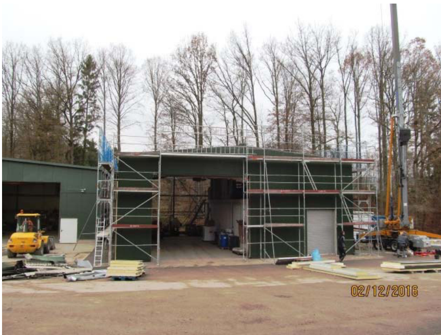
Abb. 4.4: Ausführung der Wärmeisolierung an der Garagenhalle / Gasübergabestation
