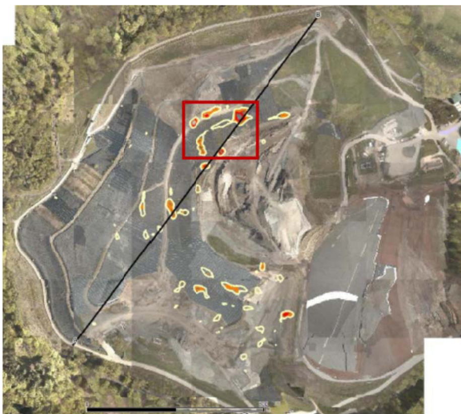
Abb. 11.2: Festgestellte Emissionsaustritte an der Deponieböschung
