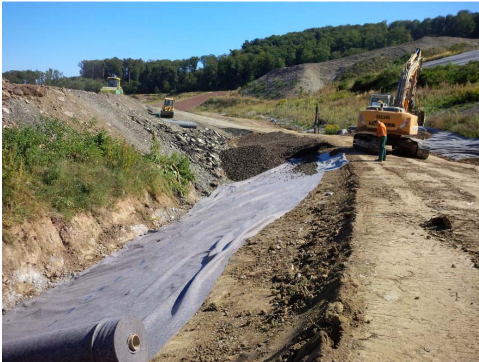
Abb. 4.2: Aufbau der Entwässerungsschicht auf der Trenndammböschung
