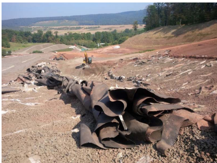
Abb. 4.1: Abräumen der Rutschmasse
