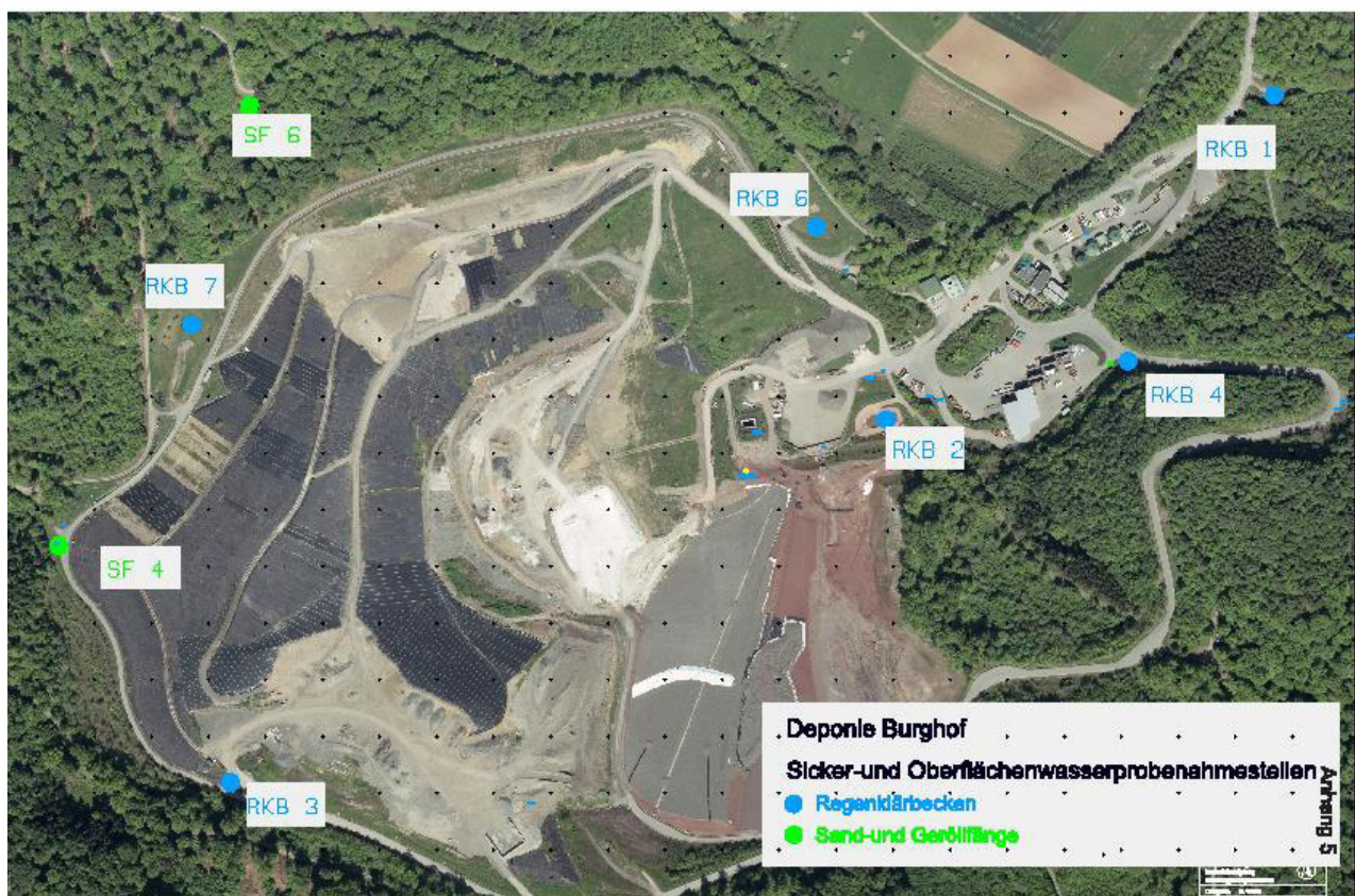
Abb. 8.8: Standorte der Regenklär- bzw. Rückhaltebecken 2017
