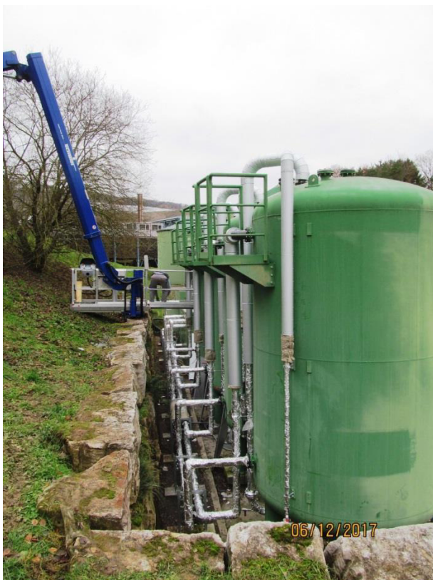
Abb. 4.7: Isolierungsarbeiten an den neuen Leitungen
