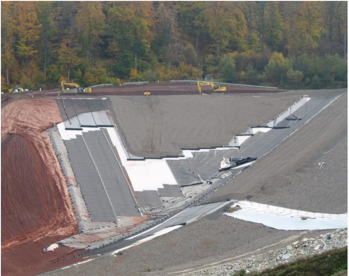
Wiederherstellung der Basisabdichtung im Deponieabschnitt X inklusive des Einsatzes von Geogittern zur Gewährleistung der Standsicherheit im Bauzustand
