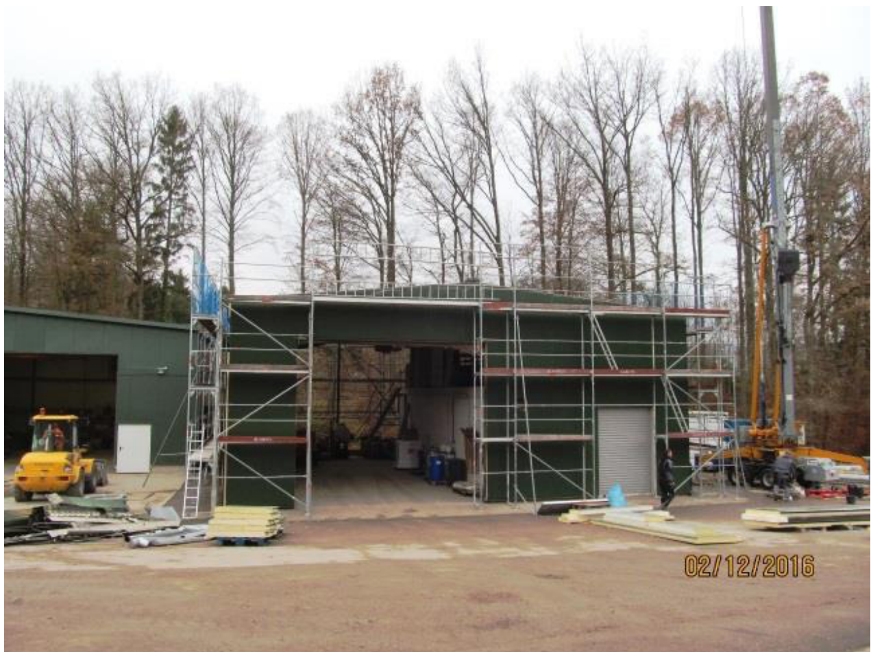
Abb. 4.4: Ausführung der Wärmeisolierung an der Garagenhalle/Gasübergabestation
