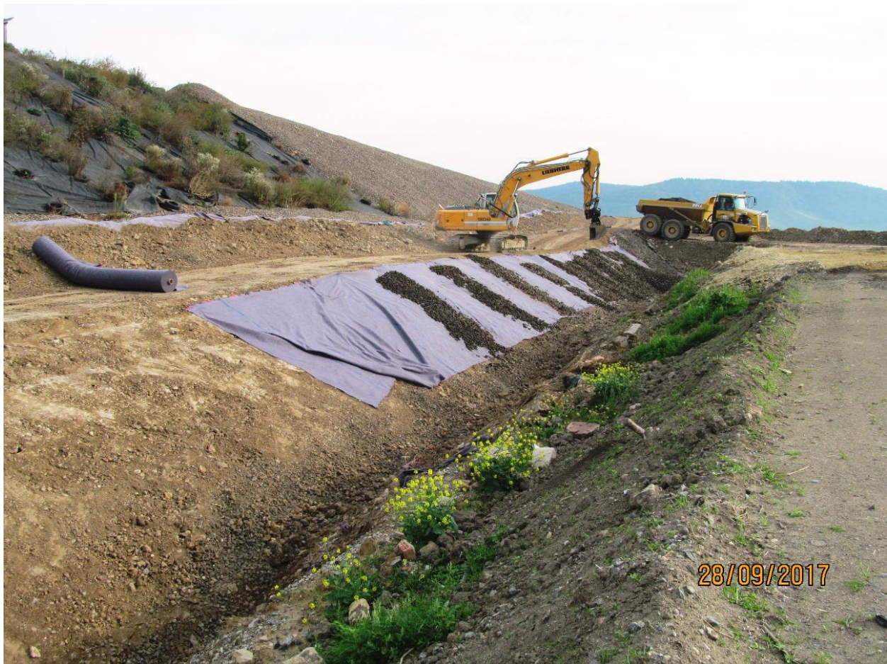
Abb. 4.2: Aufbau der Entwässerungsschicht auf der Trenndammböschung
