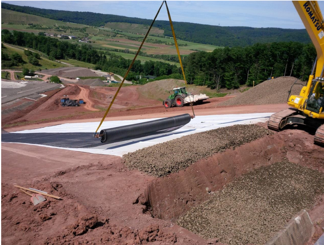
Abb. 4.1: Errichtung eines Testfeldes für Fahr- und Bremsversuche
