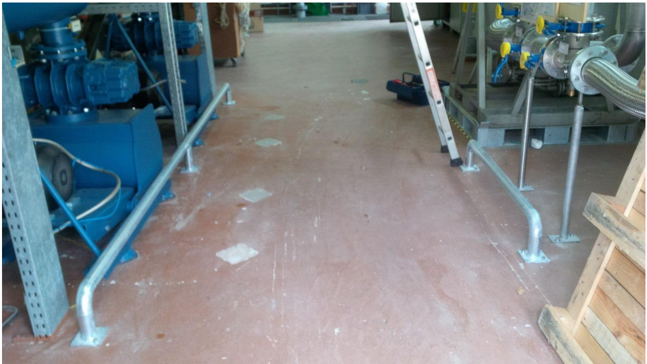
Abb. 4.5: Neue, breitere Gasse in Verdichterstation und Anfahrerschutz
