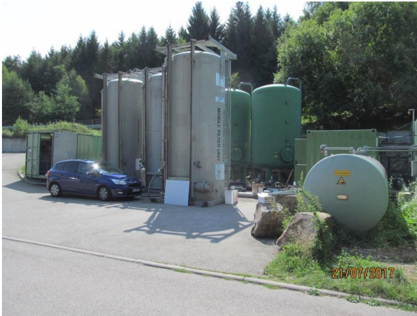
Abb. 4.6: Umbau von mobilen (grau) auf stationäre (grün) Aktivkohle-Behälter
