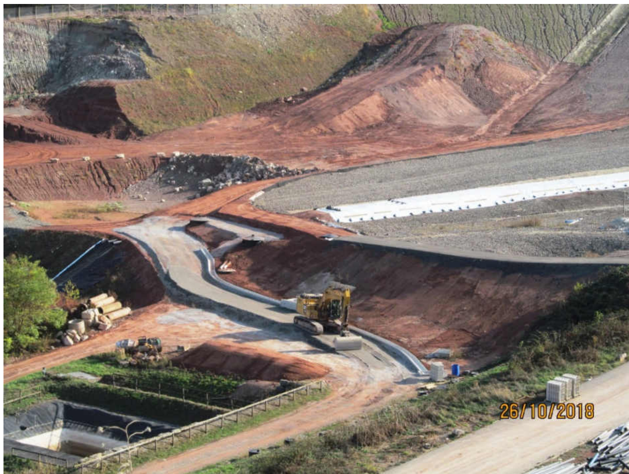
Abb. 4.2: Herstellung Zufahrtsstraße und Entwässerungseinrichtungen im Bereich des Fußdammes
