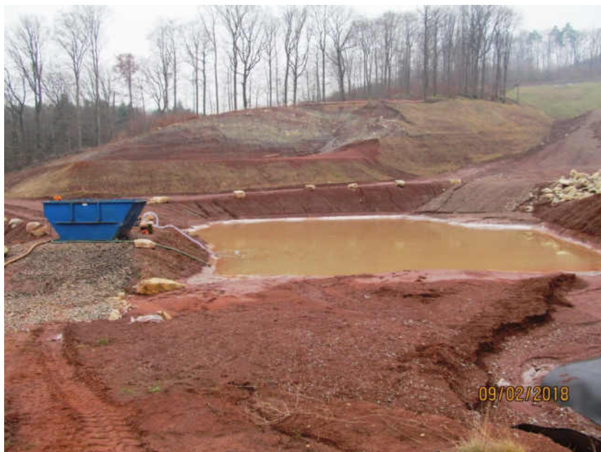
Abb. 4.1: verschlammtes Sedimentationsbecken mit Entwässerungscontainer zur Entschlammung des abgepumpten Wassers
