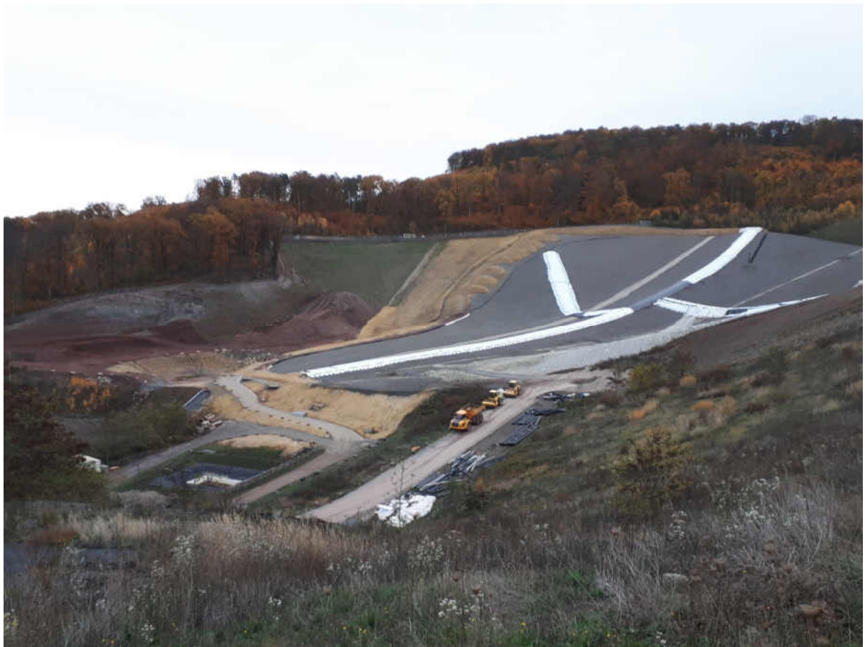
Neu hergestellte Monoflächen im Deponieabschnitt X und Spritzbegrünung östlich und nördlich der Einbauflächen
