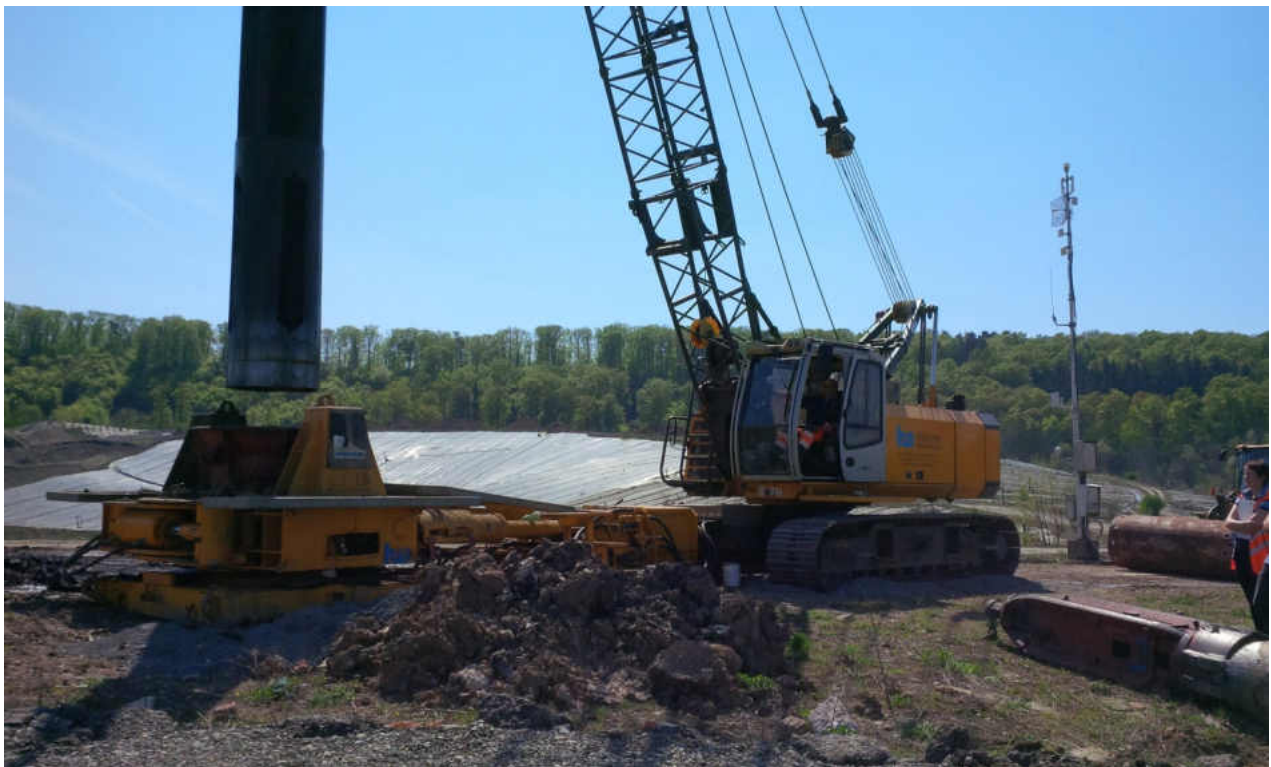
Abb. 4.4: Bohrgerät für neue Gasbrunnen
