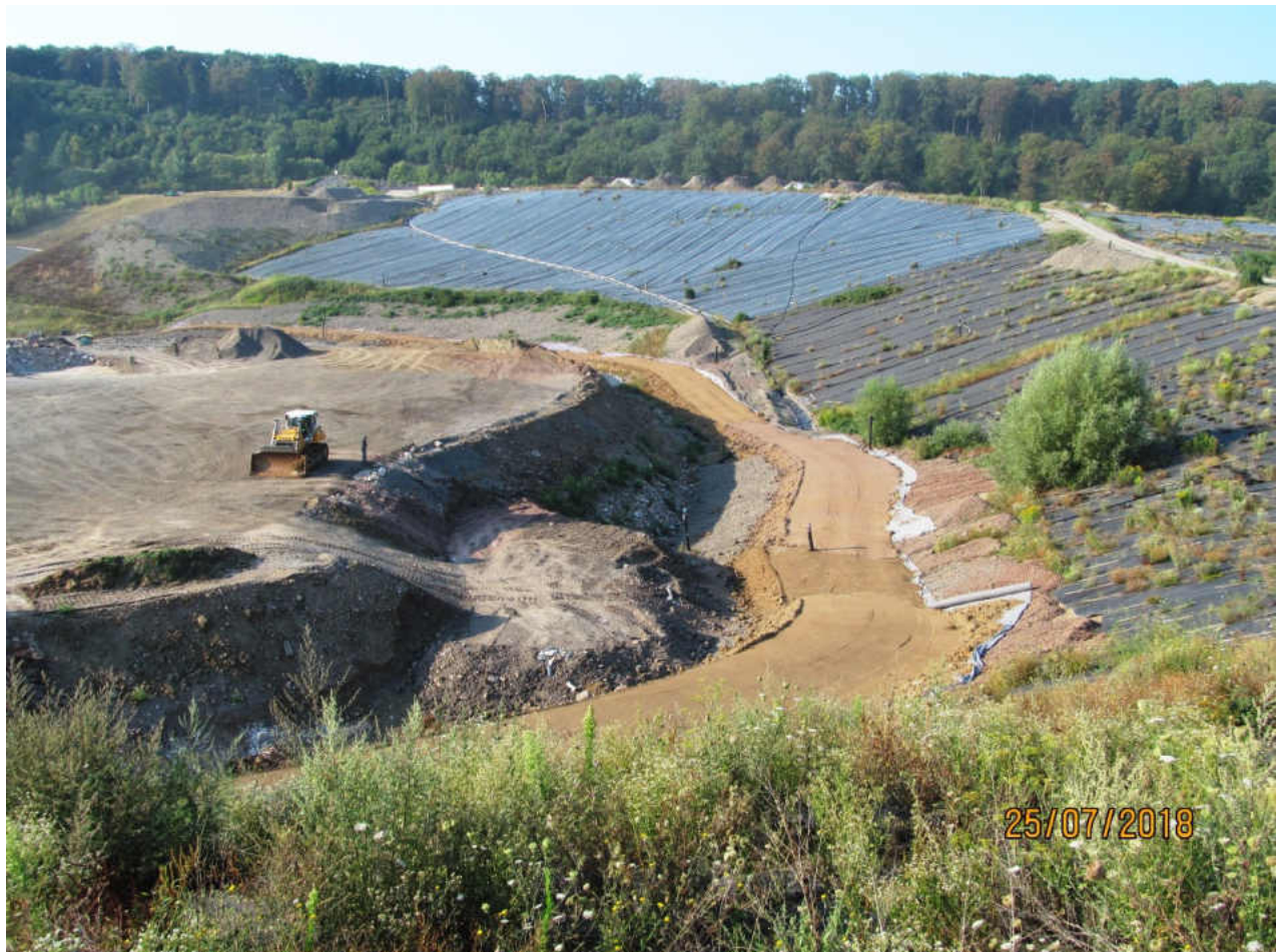
Abb. 4.3: Zwischenabdichtung in der Kesselfläche
