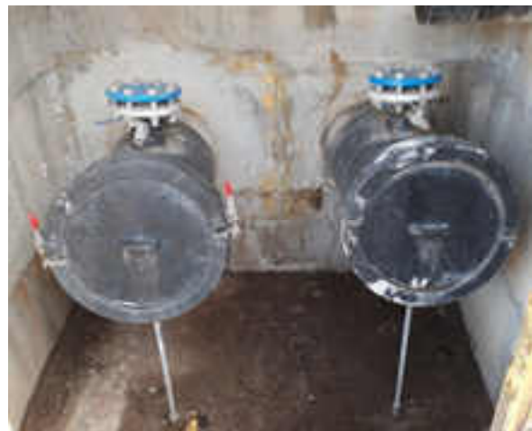
Abb. 4.6: Sanierter Spülkopf (links)
