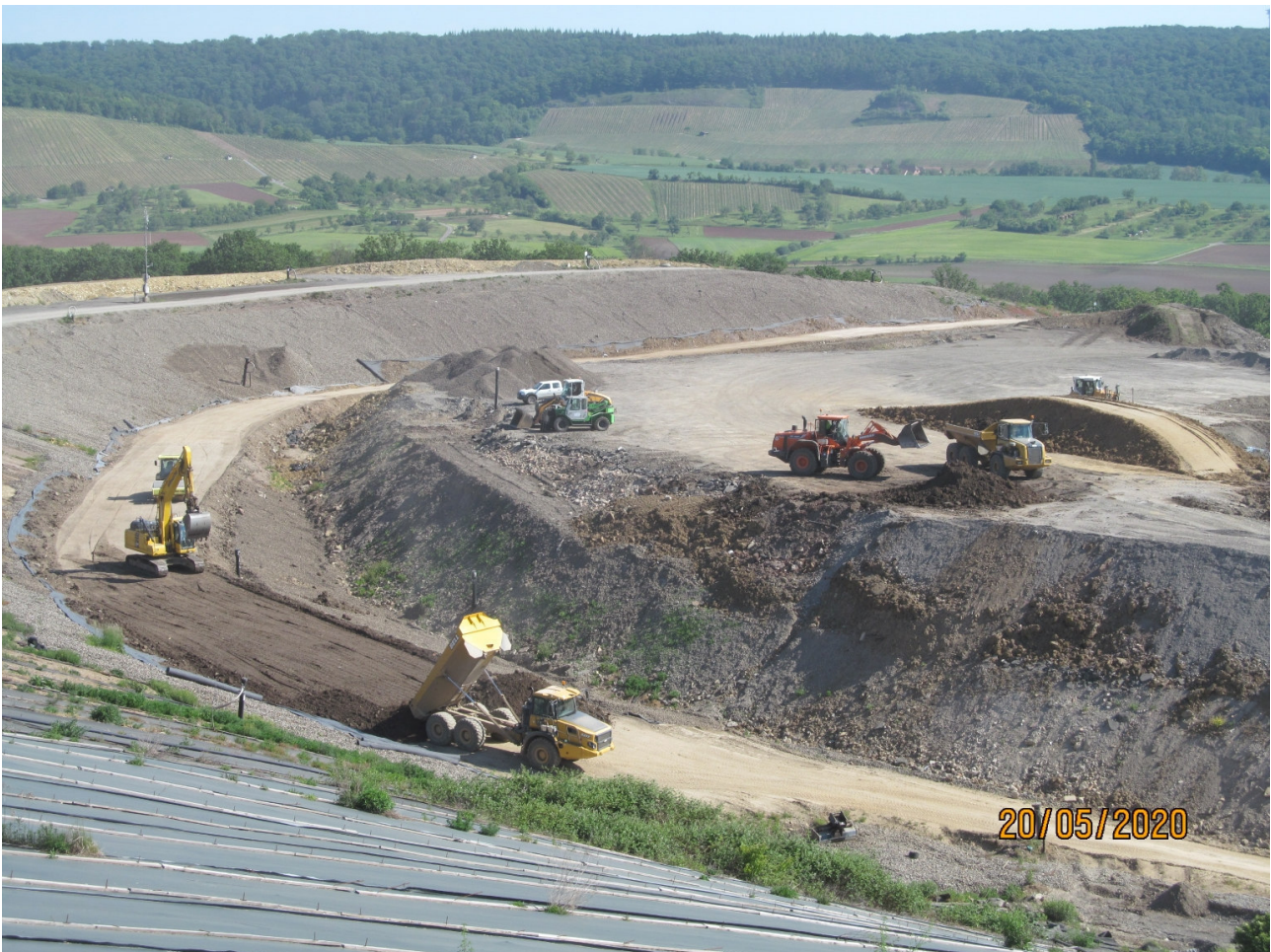
Abb. 4.1: Zwischenabdichtung in der Kesselfläche
