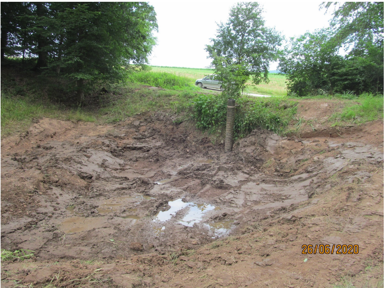
Abb. 4.6: Schlammfang Nordböschung in entschlammtem Zustand
