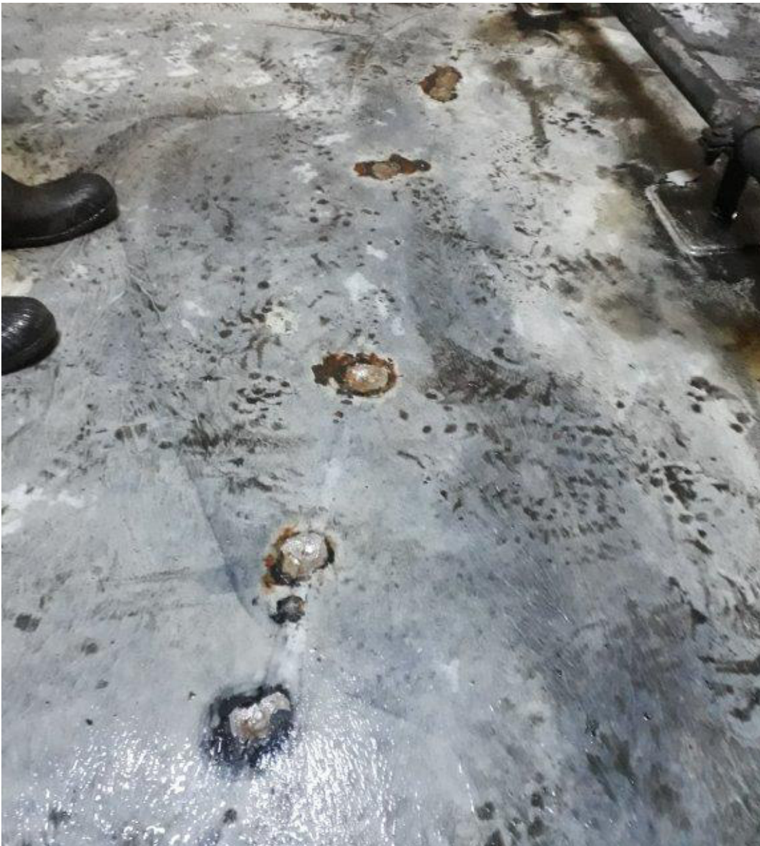
Abb. 4.2: Aufnahme vom Inneren des Speicherbeckens vor der Sanierung
