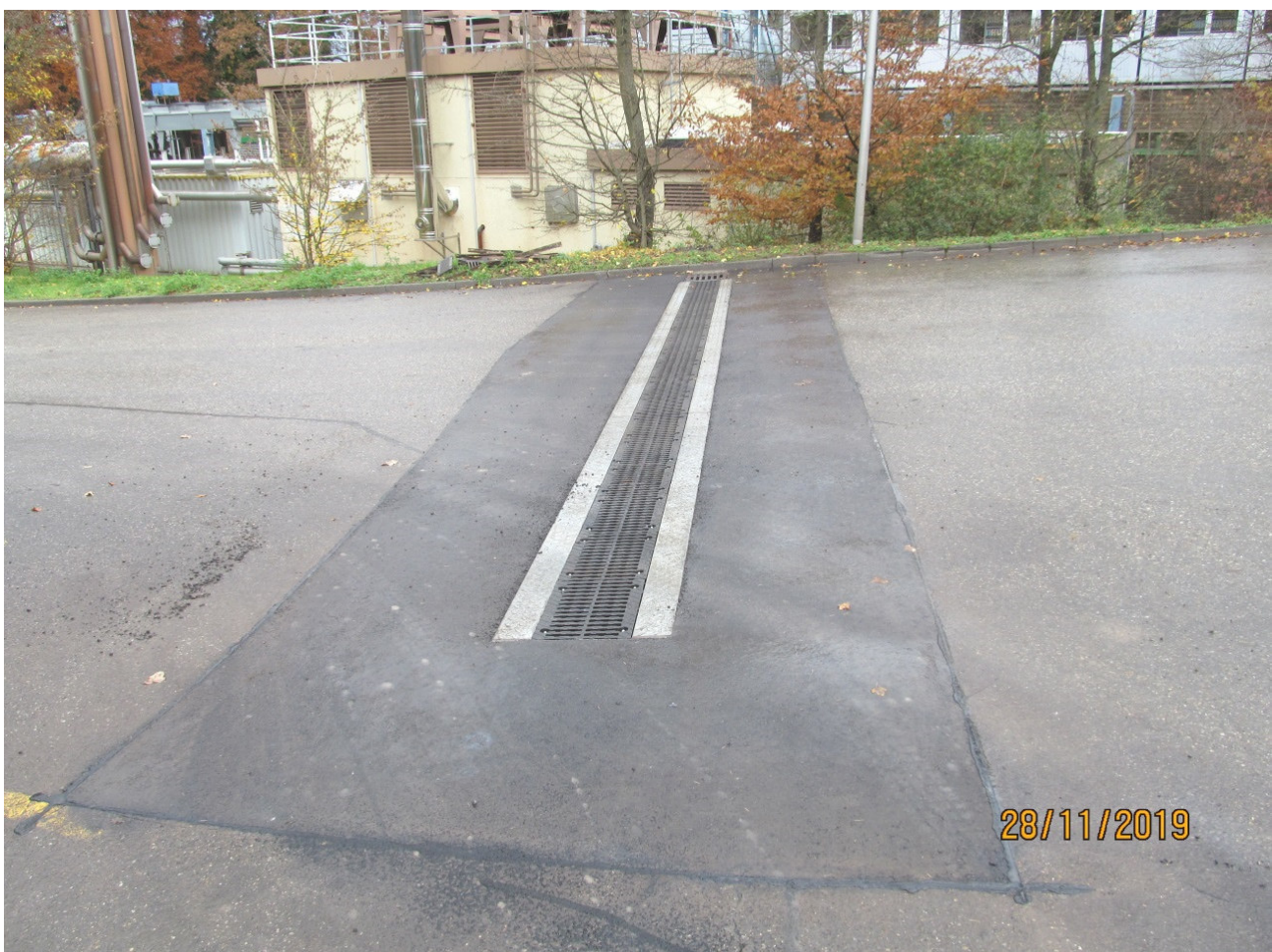
Abb. 4.4: neu gesetzte Rinne auf der Deponierandstraße
