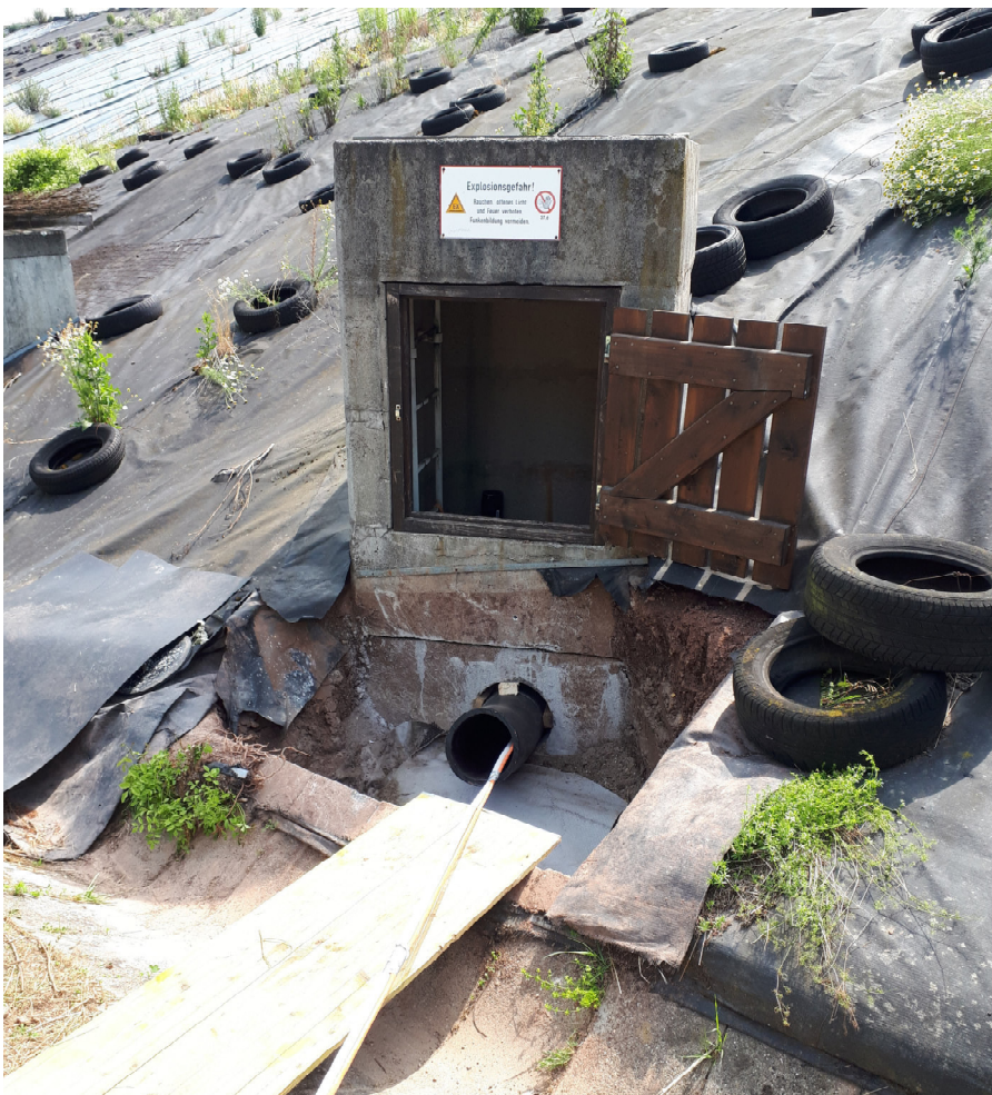
Abb. 4.2: Hilfsvorrichtung zum Einziehen der Relining-Rohre an Haltung S7.6
