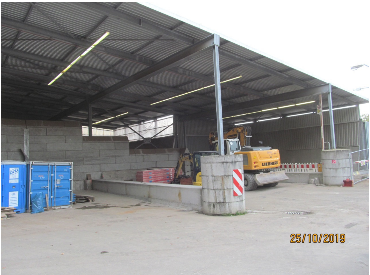
Abb. 4.3: Fundament der Zwischenwand in Umladestation
