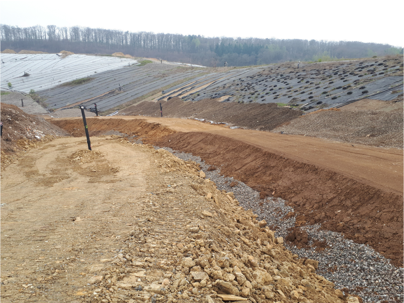
Abb. 4.1: Zwischenabdichtung in der Kesselfläche
