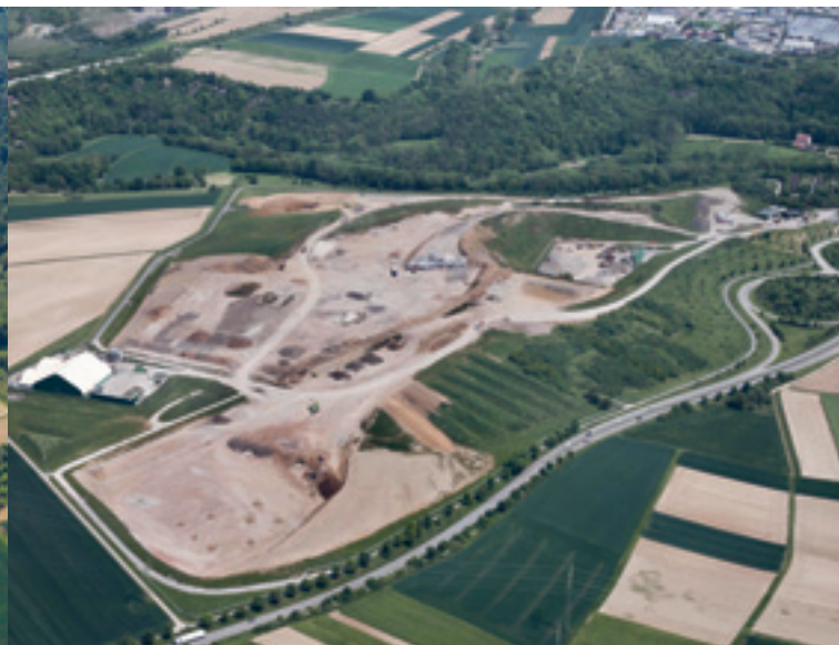
Deponie AM FROSCHGRABEN
